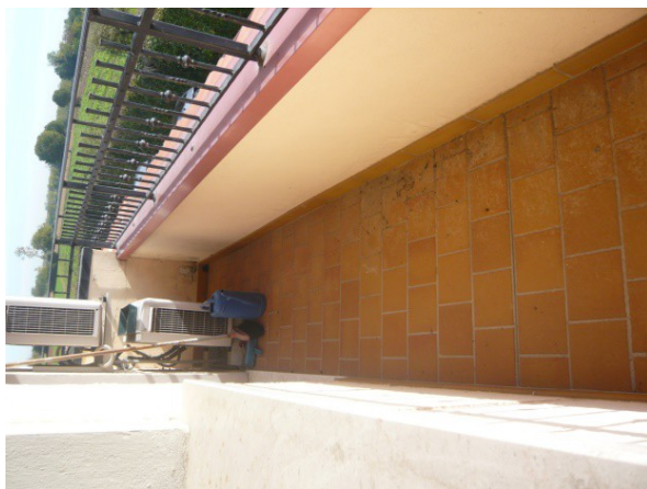
TERRAZZO LATO SUD
