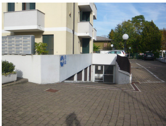
RAMPA DI ACCESSO
